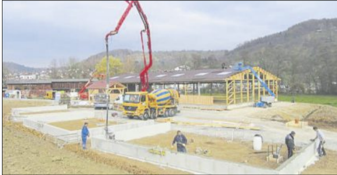
Ein Fundament wird errichtet.
