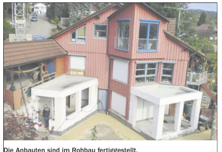
Die Anbauten sind im Rohbau fertiggestellt.
